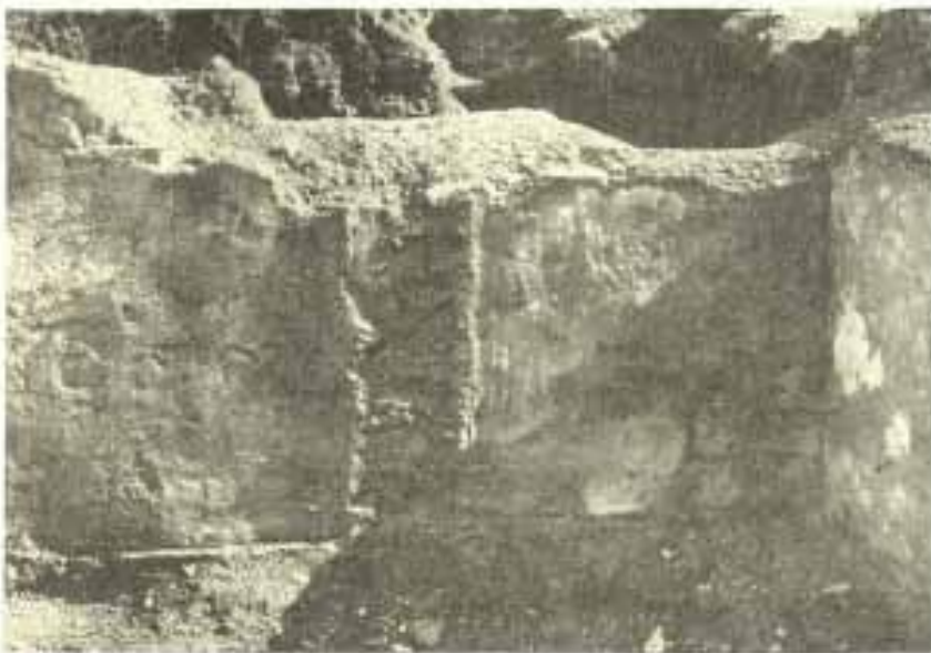
Εἰκ. 4. Ἡ ἐσωτερικὴ ὕψος τῆς Α πλευρᾶς τοῦ προσκτίσματος.
